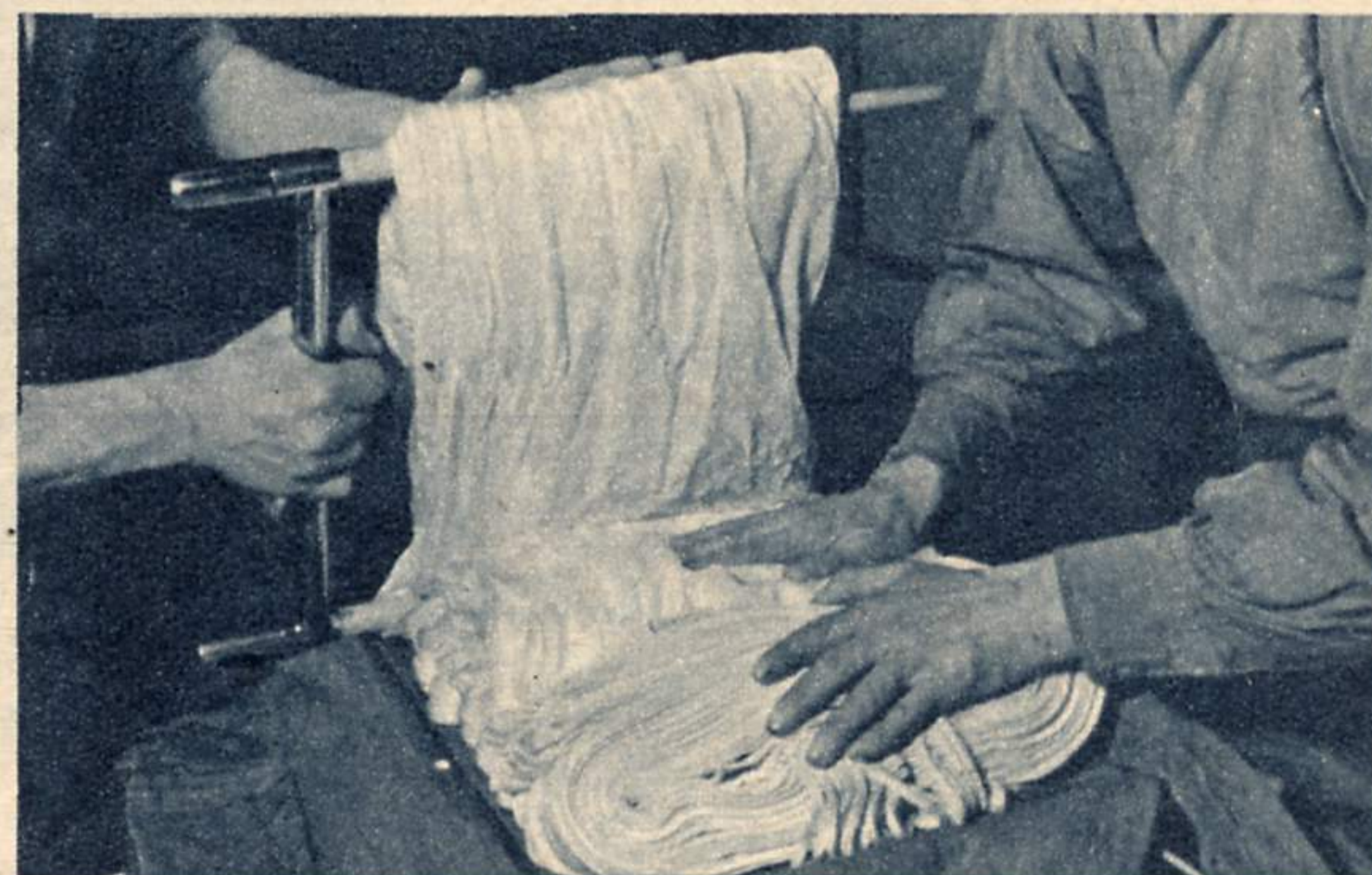
Mittels einer besonderen Hilfsvorrichtung legen die Männer die letzten Falten der luftigen Seide in den Sack
